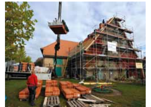
Die neuen Dachziegel werden angeliefert.
