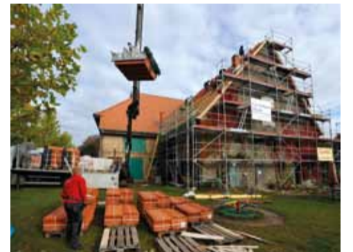
Die neuen Dachziegel werden angeliefert.
